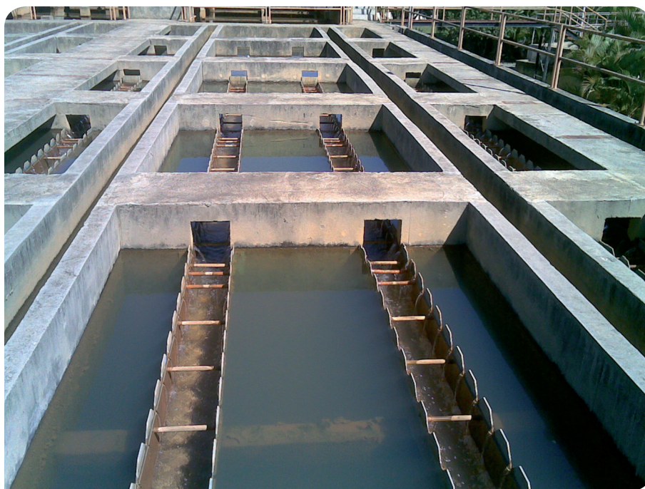
Figura 10: Tanques de decantação de uma estação de tratamento de água.
