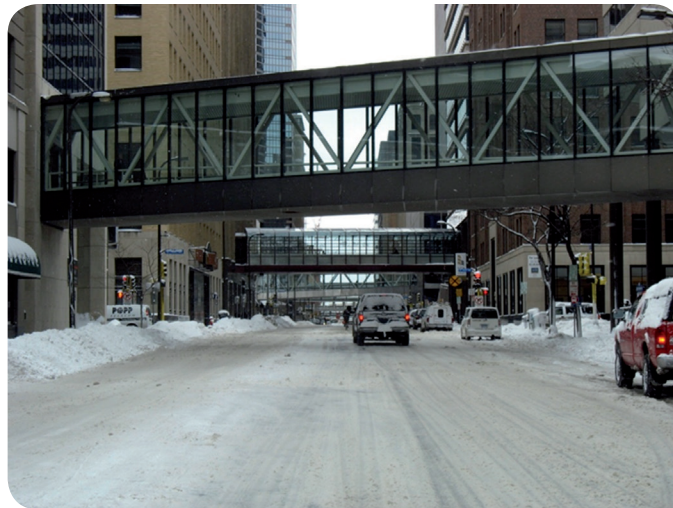
Figura 6: As passarelas são importantes recursos para a segurança e a circulação de pedestres tanto em ruas quanto em estradas.
