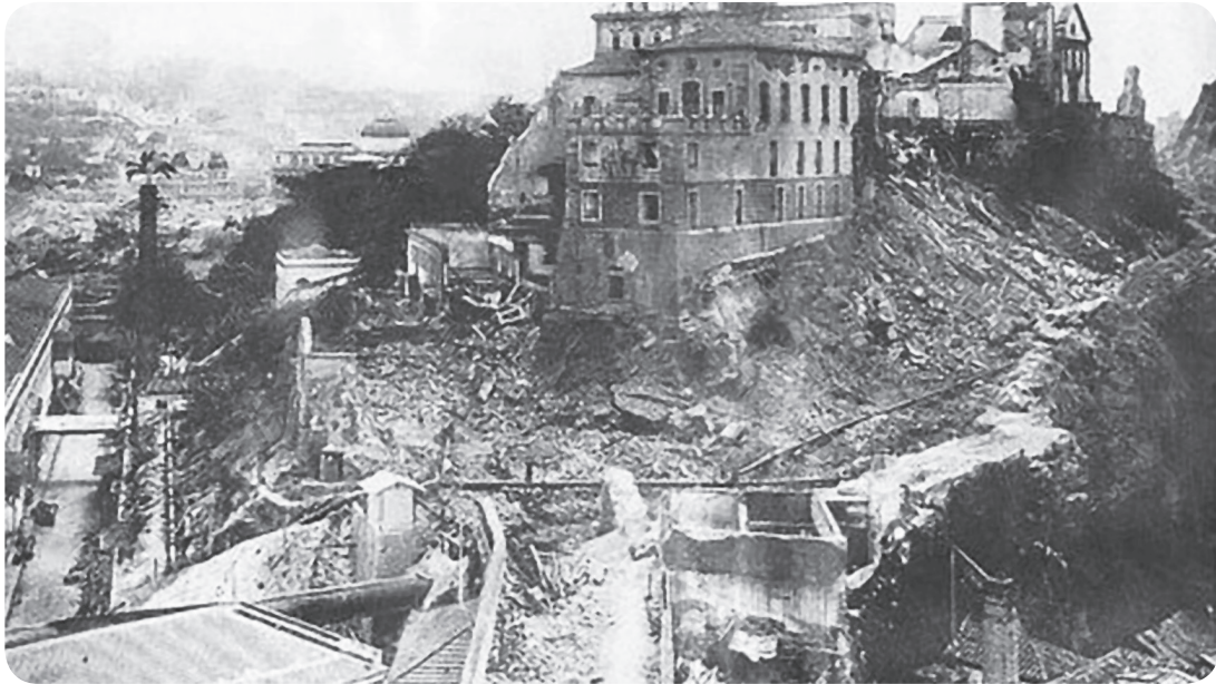
FIGURA 6: Demolição do Morro do Castelo (1922-1930).
